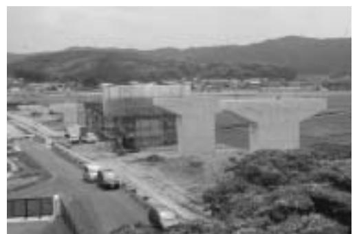
宮田遠賀線道路改良工事(木守～今古賀)
