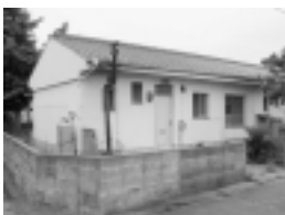
別府町営住宅
