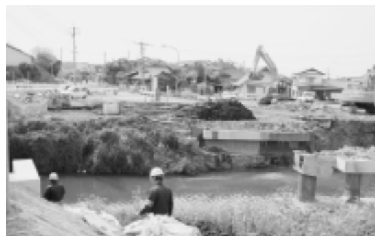
戸切川橋梁架替工事（古川橋）
