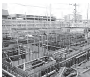
鉄筋と型枠を組んで…
