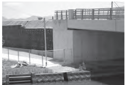
補強土壁工事等が行われる現場
