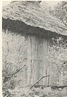
竹壁の薪小屋
