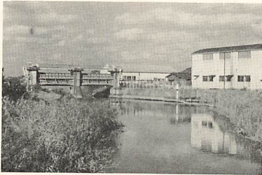
広渡排水機場及樋門
