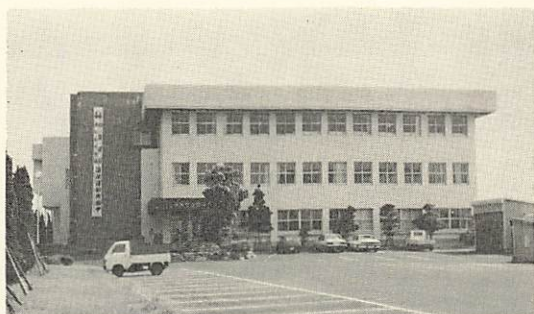
遠賀町中央公民館
