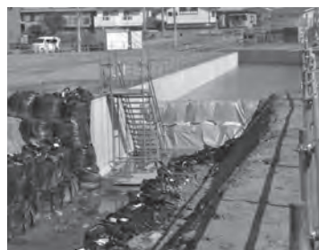
駅南地区島田川付け替え工事現場
