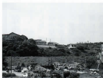
若葉台 (がけ崩れ)
