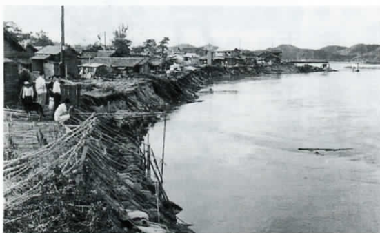
川沿いには、たくさんの土のうが積まれています
