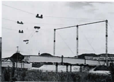
遠賀バイパス（現国道3号線）の建設は急ピッチに進みました。写真は西川に橋を架けている風景。
