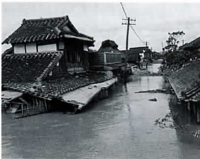
遠賀川決壊による大水害（昭和28年）
