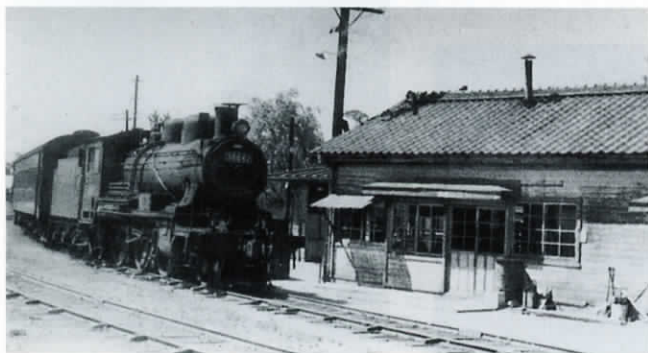
昭和35年の国鉄芦屋線廃止直前に写されたものです
