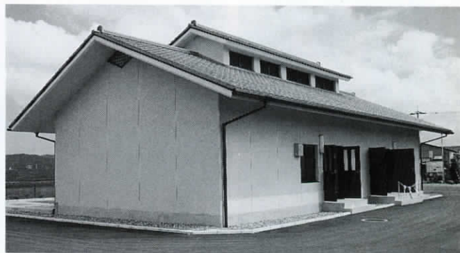
▲老良地区の汚水処理場
