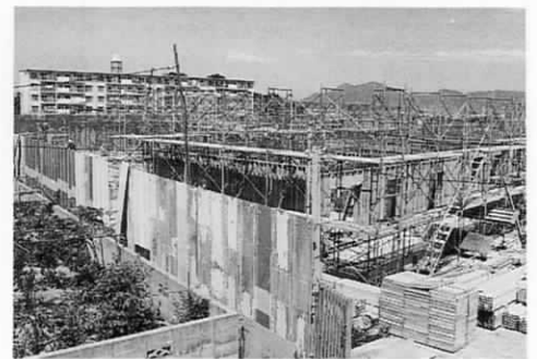
着々と工事が進む東町住宅地区改良事業
