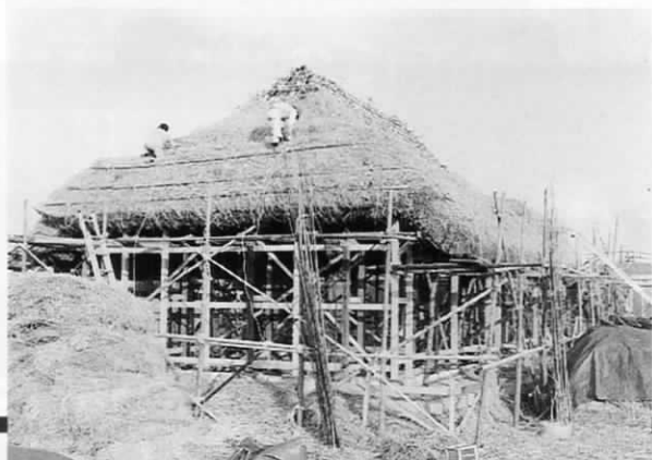
材料のカヤは、大分県九重町の産、220駄（1駄は135紐）。これだけのカヤを葺くのに5人がかりで約20日間を要しました。
