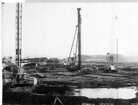
着々と工事が進む「ふれあいの里」。工事中の生きがい健康施設ゾーンは、来年10月、完成予定。
