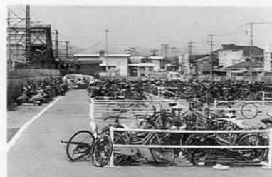
突然の雨だつて、へっちゃら 遠賀川駅東側自転車駐輪場 にシェルター（屋根） が設置されます
