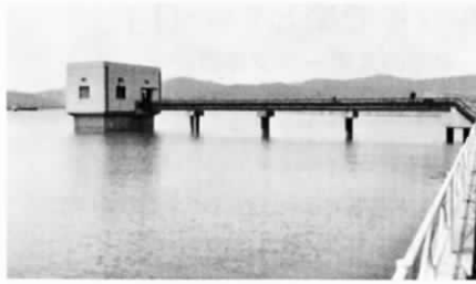
浮州池水源 取水塔のポンプで西部浄水場に送水します。
