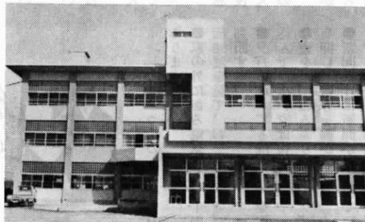
島門小学校々舎増改築
