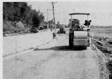
町道尾倉線の舗装工事
