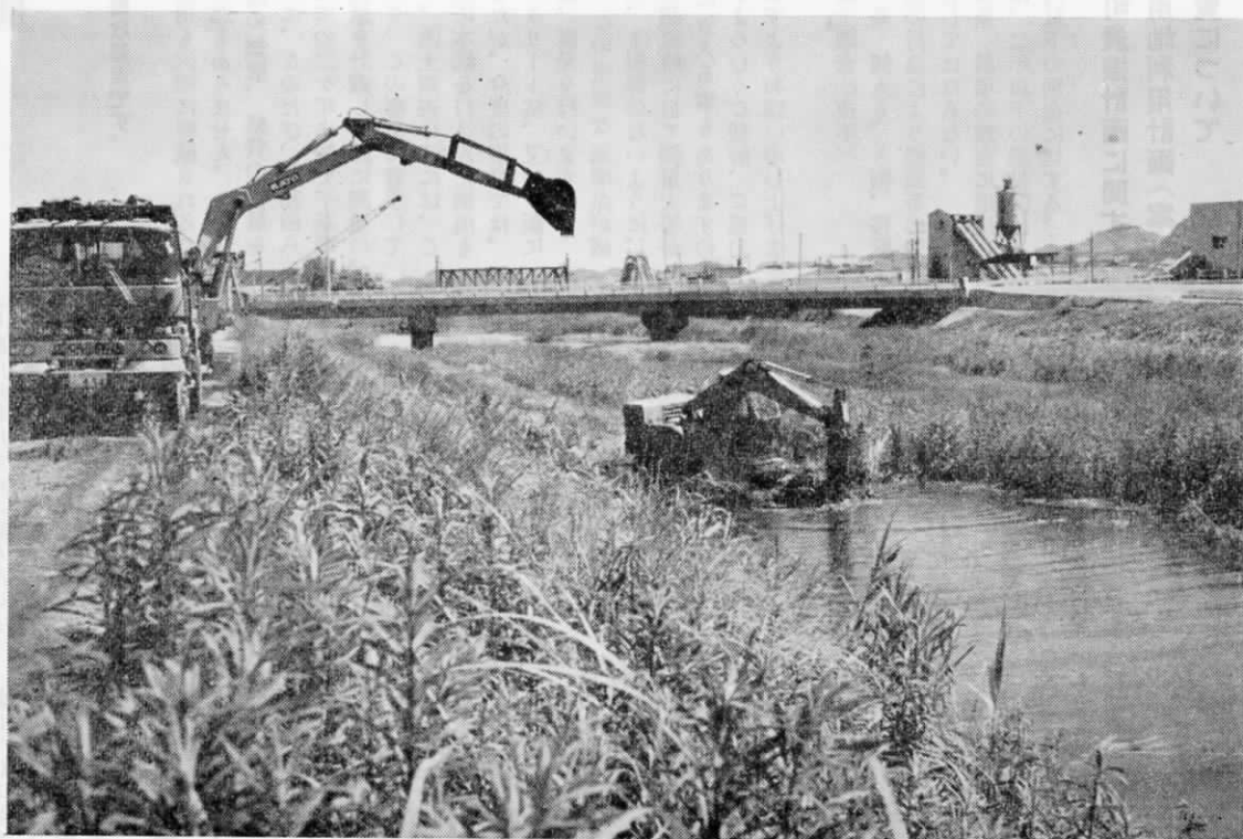
雨期を前に西川河川第1期浚渫工事進む。これは一般鉱害復旧工事として県費3千万円の予算で、大字木守、今古賀、広渡地区1.2kmにわたり掘削2万m 3 を見込み本年11月完成予定。
