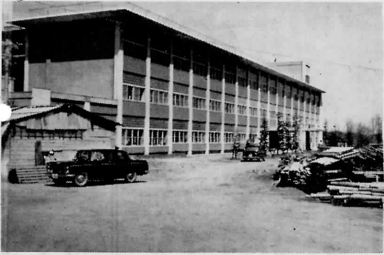
(完成した島門小学校鉄筋防音校舎)
