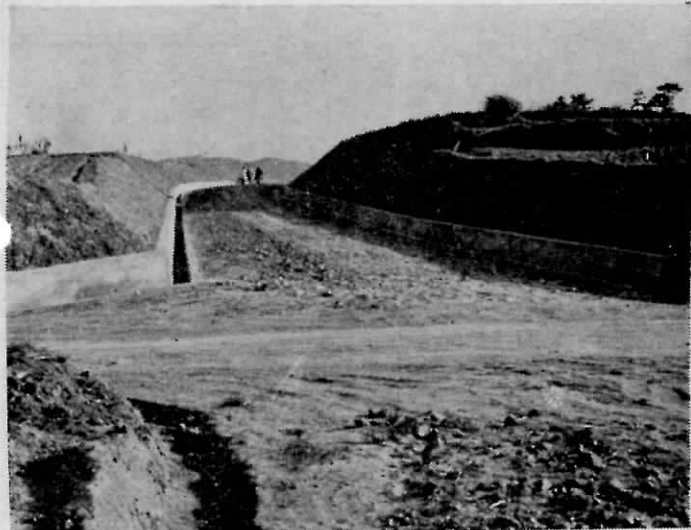
完成した尾崎(先野々)地区の繁就山手線道路工事
