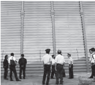
塩害から被害を防ぐ防潮柵
