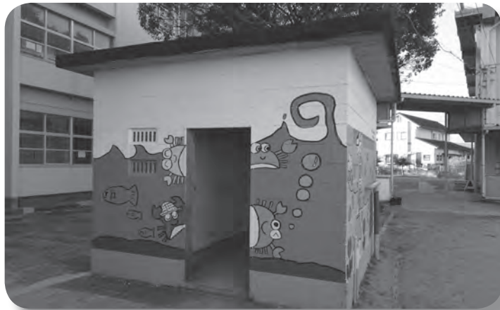
利便性の悪い島門小学校の屋外トイレ
