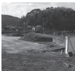
工事が開始された山手線道路
