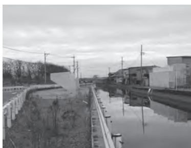
吉原川に新設される橋梁の土台
