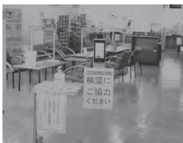
現場玄関に設置したサーマルカメラ
