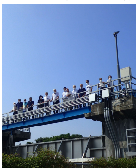
▲広渡排水機場の吉原川水門
