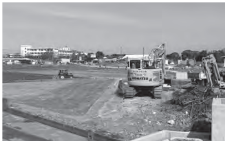
戸切川とJRの間の補強土壁工事
