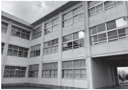
改修予定の遠賀中学校外壁
