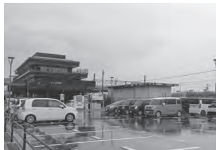
おんがみらいテラスの駐車場
