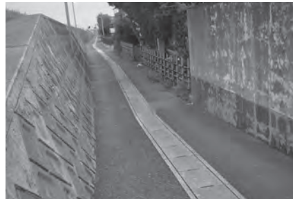
緊急車両が通りにくい狭あい道路
