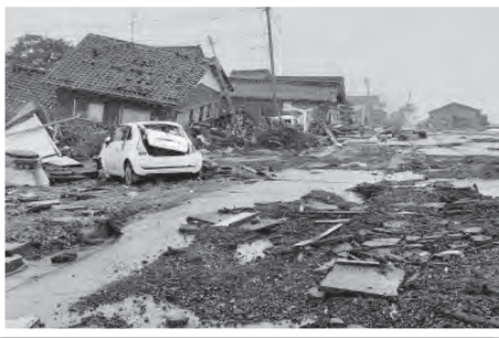
▲能登半島地震での被害状況
