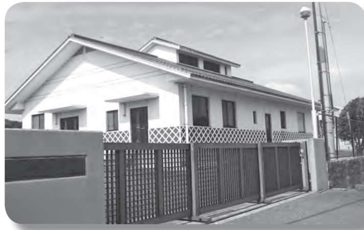
遠賀町北部浄化センター
